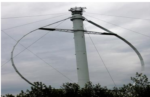
Fig.I.6 : Eoliennes de type Darrieus [14]
