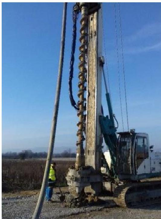
**Figure III. 8 : Renforcement des sols par inclusion rigide.**
