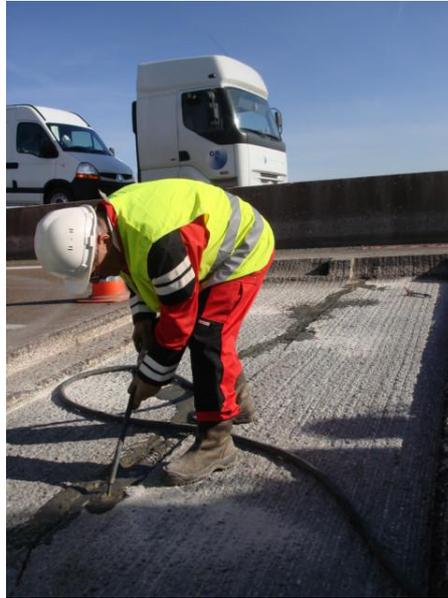
**Figure III. 5 : Réparation des couches de fondation autoroutières.**
