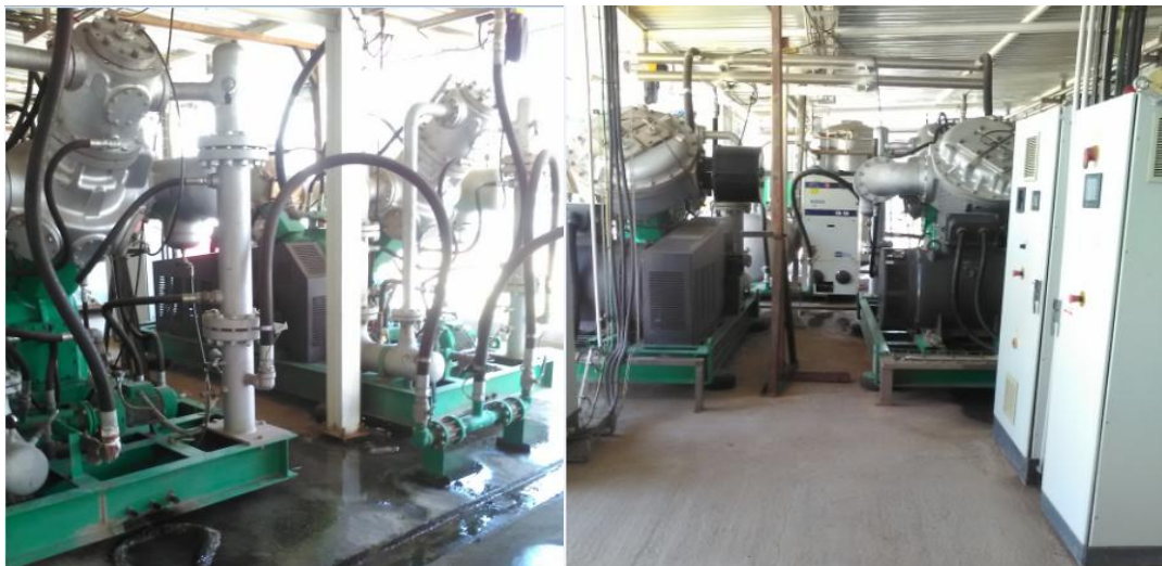
Figure II.5 : L'installation de deux compresseur « SIAD » à « Mont Djurdjura ».
