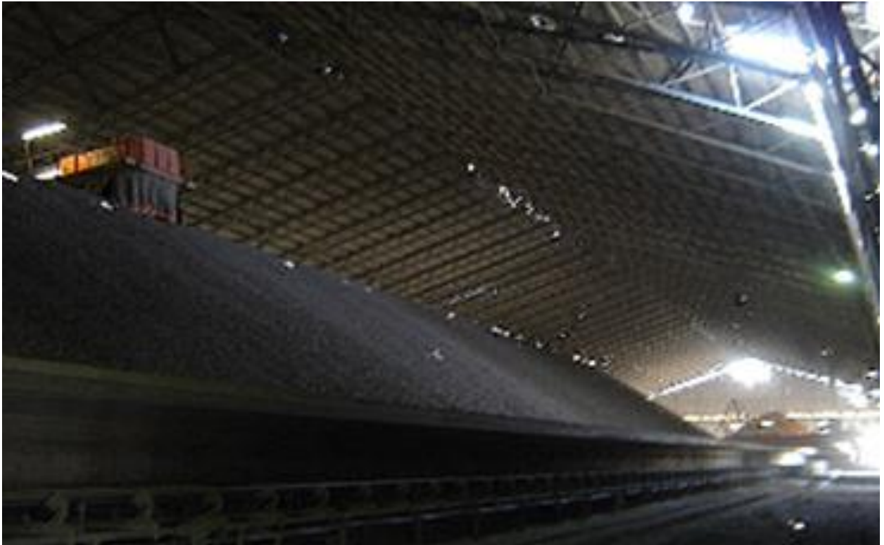
Figure I . 5: Hall de stockage des matières.
