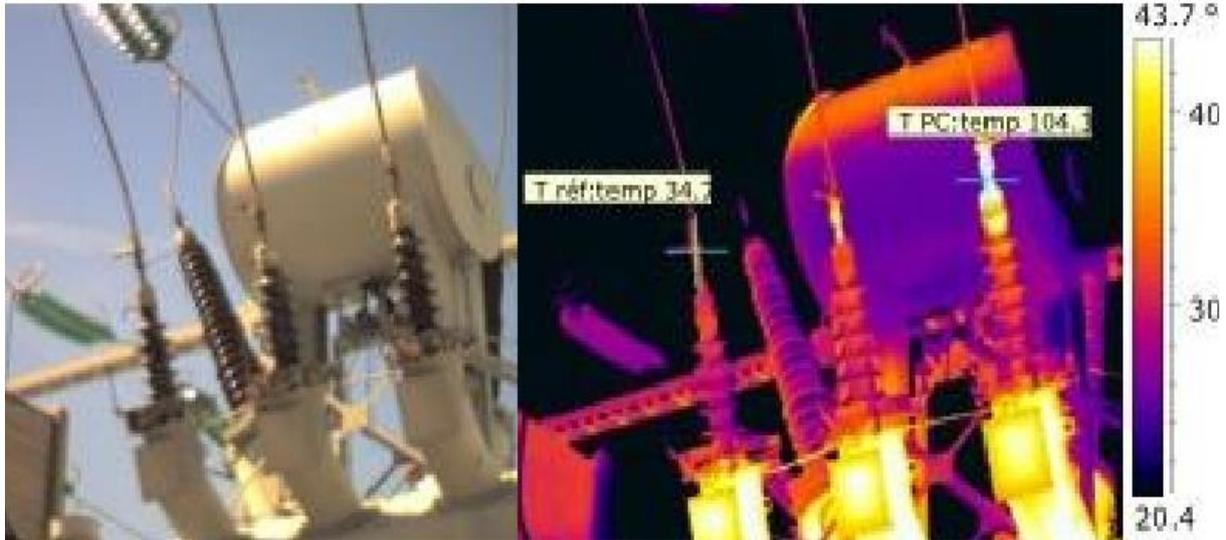
**Figure II.5:** Exemple de thermographie infrarouge sur une connexion mal boulonnée du transformateur.
