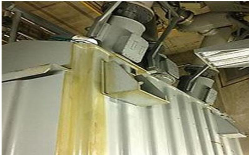
**Figure I.18:** Déformation de Fuite d'huile [17].
