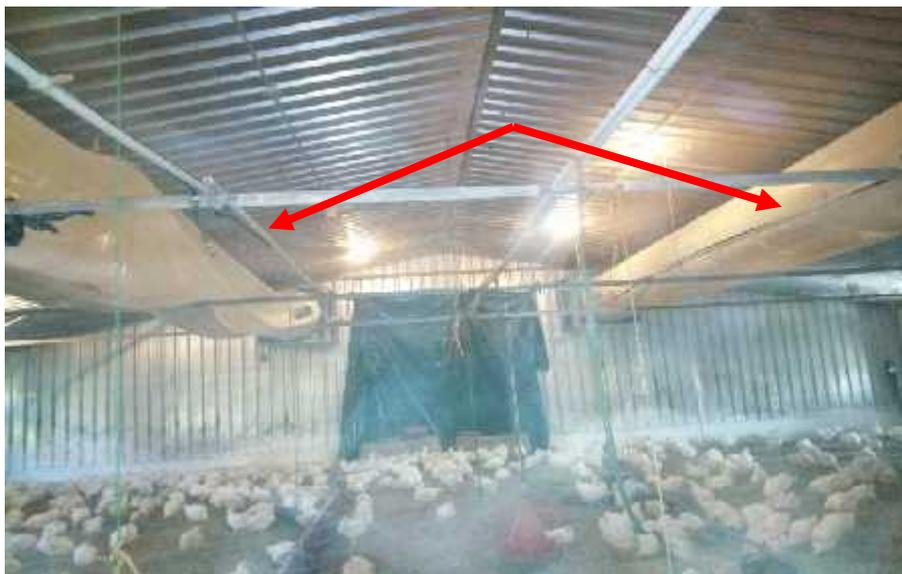
**Photo N°05 :** système de aération ( Fan-get système) de Bâtiment de production N01
