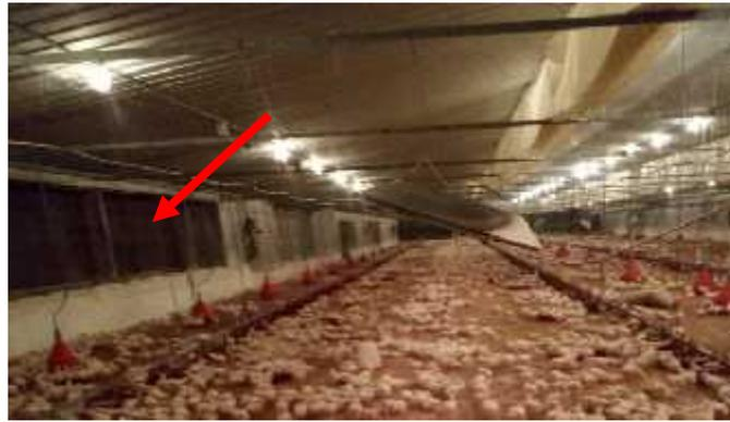
**Photo N°04 :** Vue interne de système de refroidissement Pad Cooling dans le bâtiment d'élevage.
