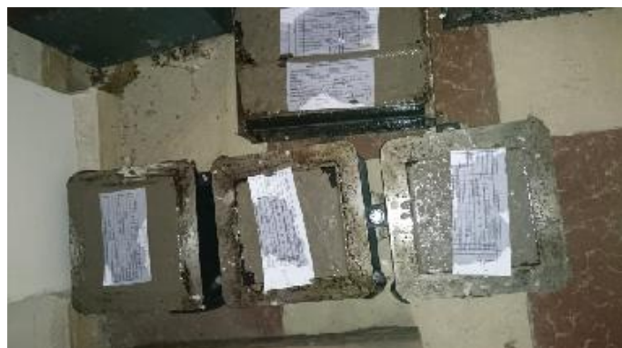
Figure IV.27. Coulage du béton.
