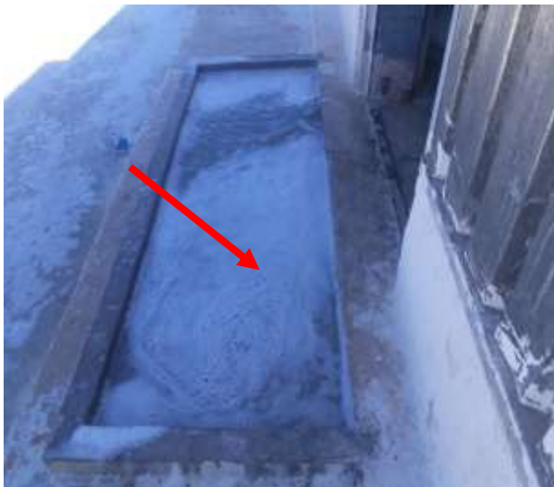
Figure 28 : Pédiluve à l'entrée du bâtiment.
