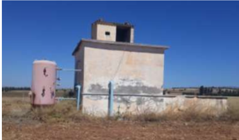
Figure 26 : La bache à eau.
