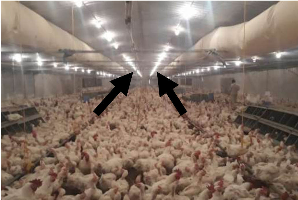
Figure 20 : Système d'éclairage à l'intérieur du bâtiment.
